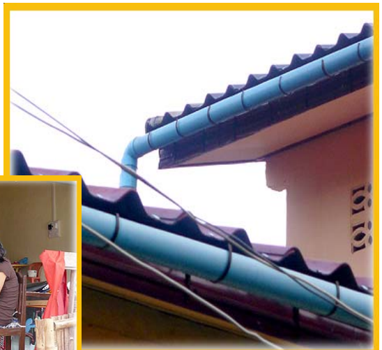
รางน้ำที่ไว้สำหรับรองน้ำฝน มีให้เห็นกันแทบทุกบ้านใน สปป.ลาว
