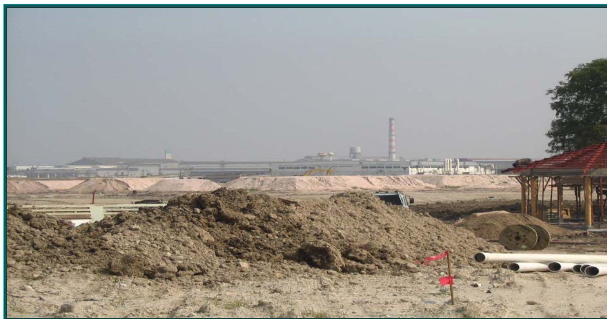
รูปที่ ๖ บริเวณที่กำลังดำเนินการปรับหน้าดินเพื่อทำสนามกอล์ฟ และมีนิคมอุตสาหกรรมอมตะนครอยู่เบื้องหลัง
