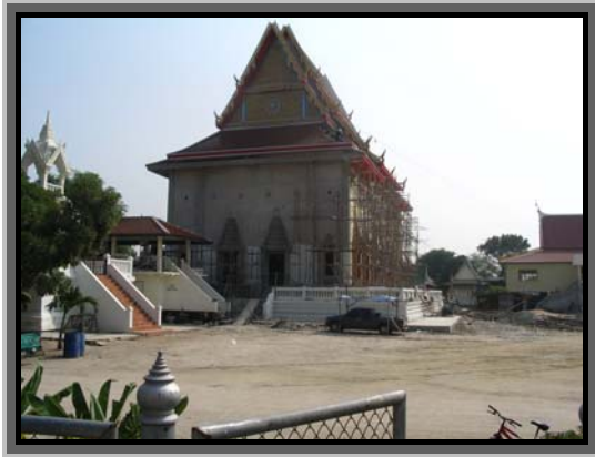
รูปที่ ๓ พระอุโบสถที่อยู่ระหว่างการก่อสร้าง
